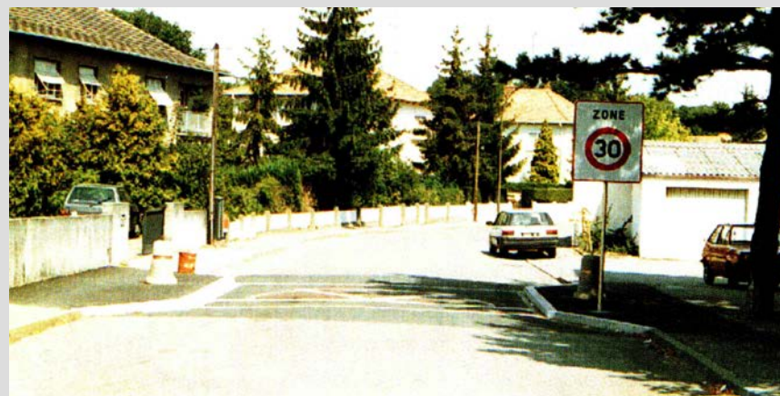
E' importante che l'accesso alle zone residenziali venga delimitato in modo chiaro ed efficace, e ben segnalato all'attenzione degli automobilisti.
