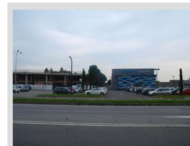
I varchi presenti fra gli edifici commerciali potrebbero essere utilizzati come percorsi di uscita dal piazzale.
