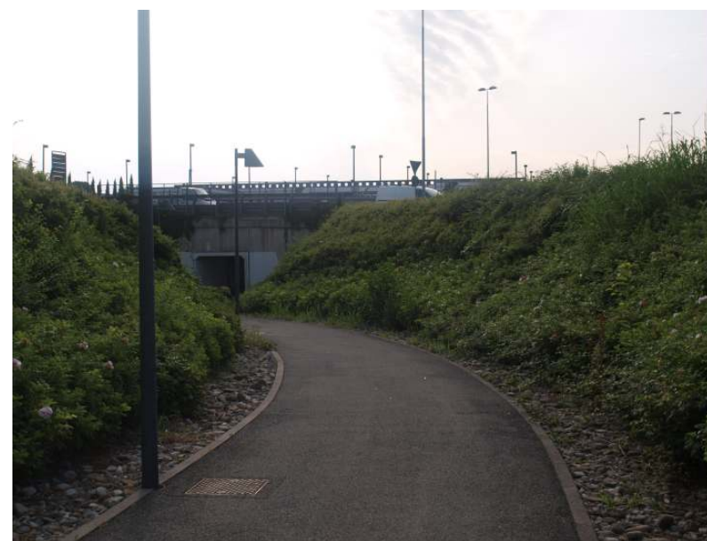
Il sottopassaggio di via Resegone / via Cavalieri di Vittorio Veneto
