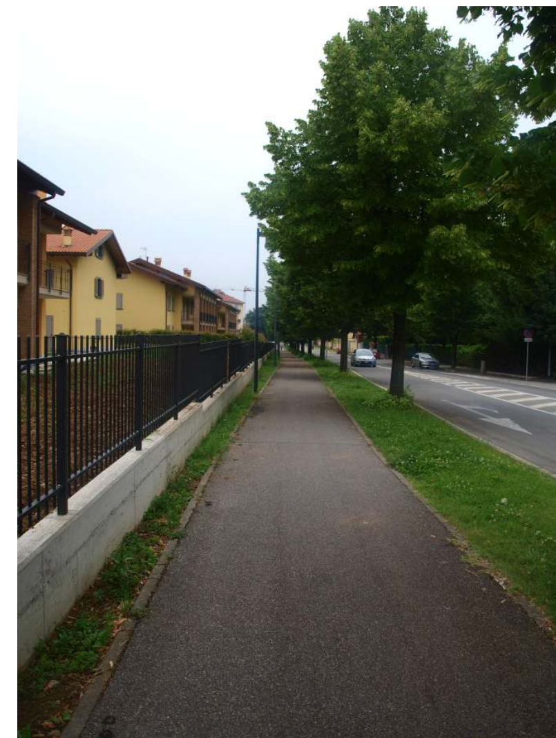
La pista ciclopedonale di via Monza
