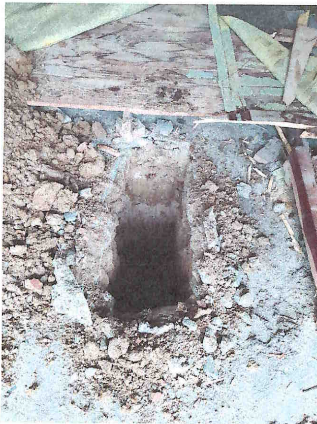
Scavo d'assaggio n.4
