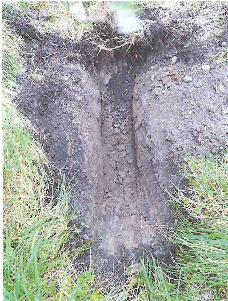
Scavo d'assaggio n.1
