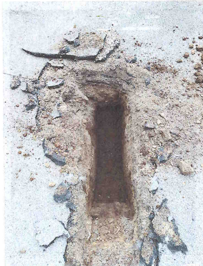
Scavo d'assaggio n.3
