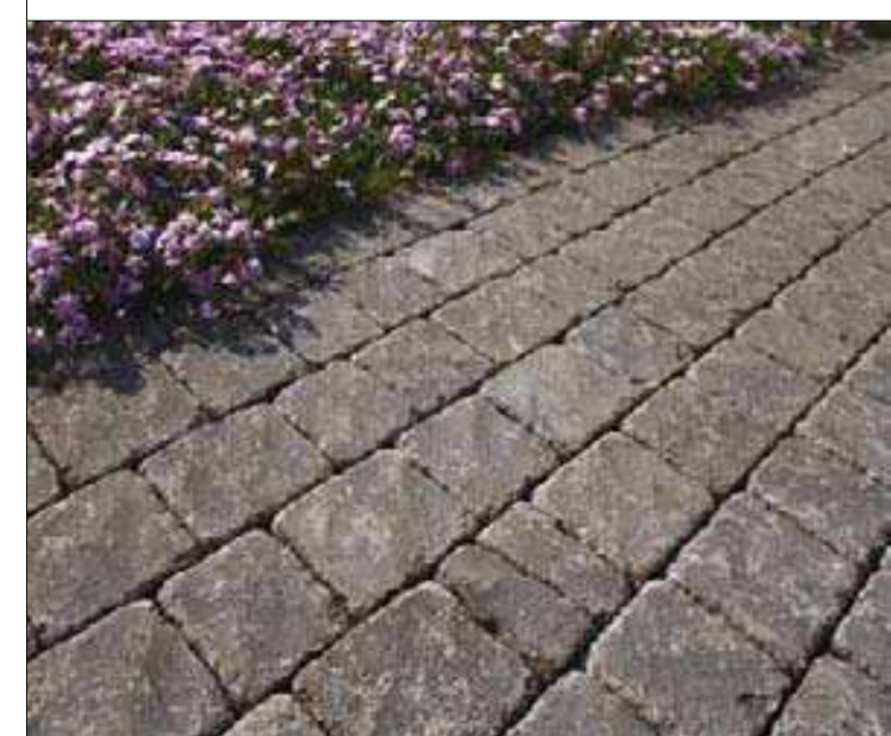
ESEMPIO DI PAVIMENTAZIONE IN MASSELLI AUTOBLOCCANTI
