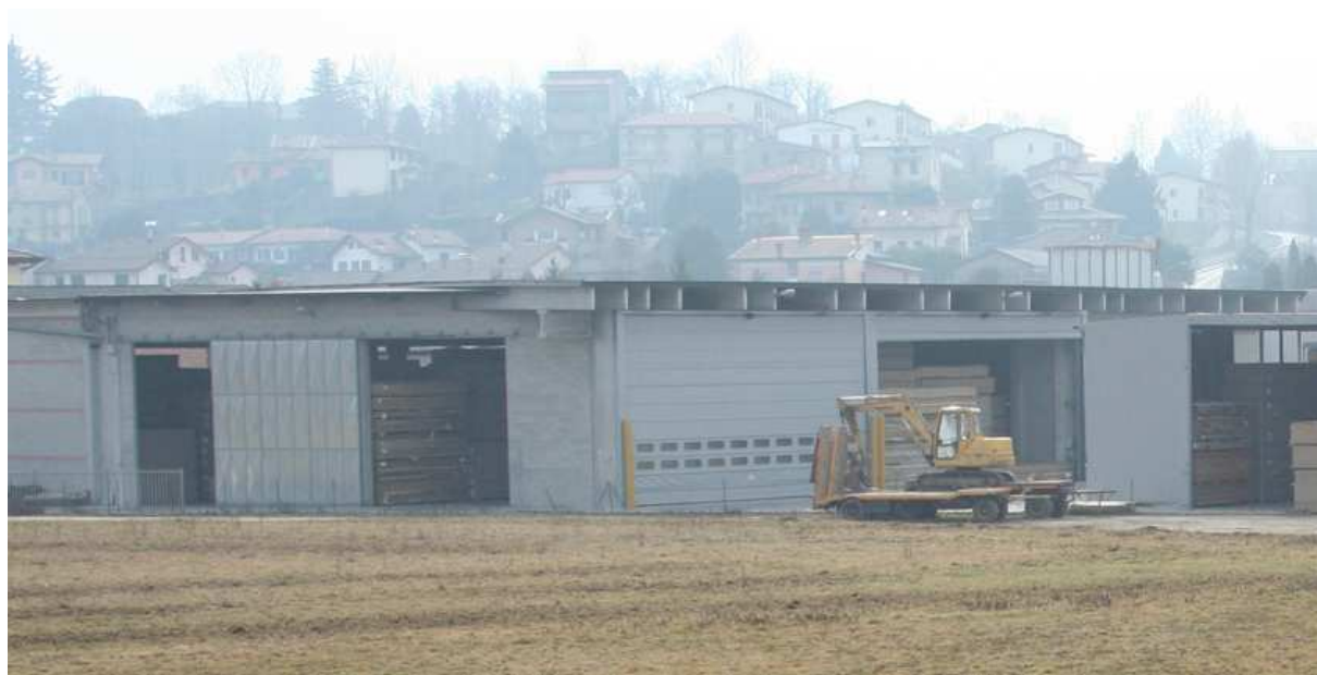
ditta "Lignum" vista dal lotto di intervento
