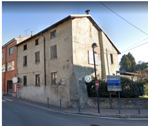
ID11 – Edificio in via Garibaldi
