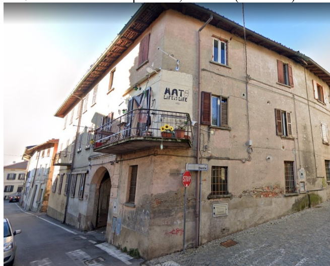
ID17 – Edificio in via Indipendenza, via Dante (Piano terra)
