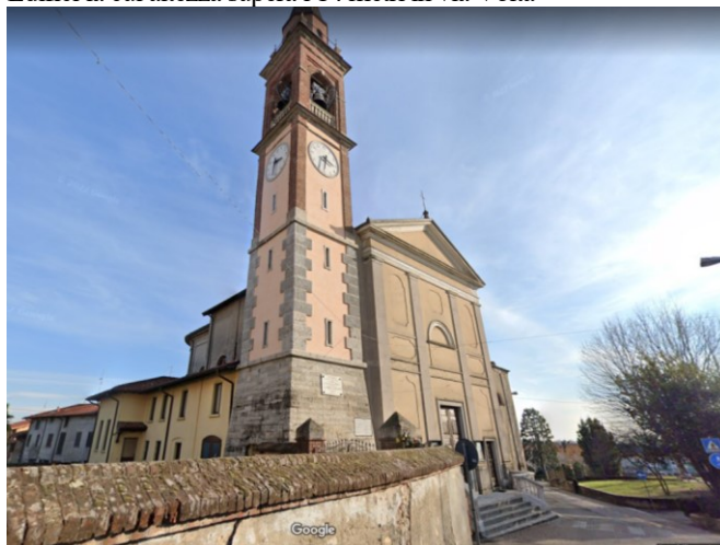
Edifici la cui altezza supera i 14 metri in via Volta
