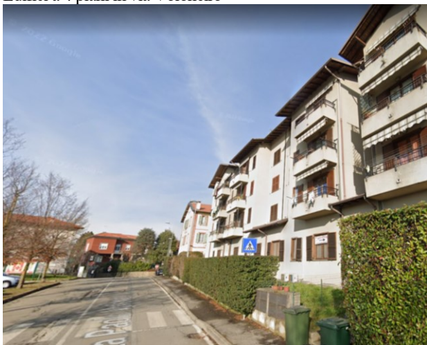
Edifici a 4 piani in via Voloneiro
