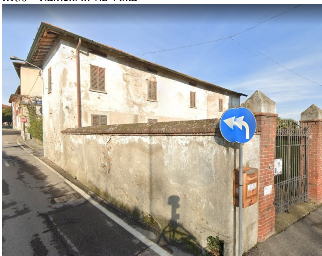
ID30 – Edificio in via Volta
