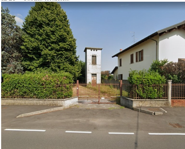
ID26 – Cabina elettricità
