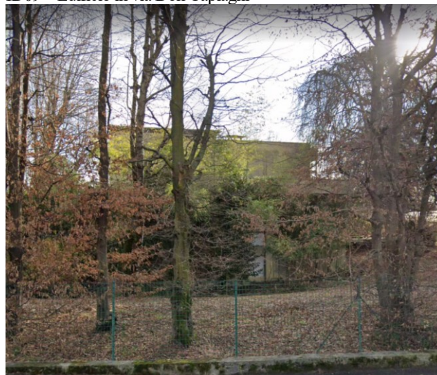
ID09 – Edificio in via Don Capiaghi
