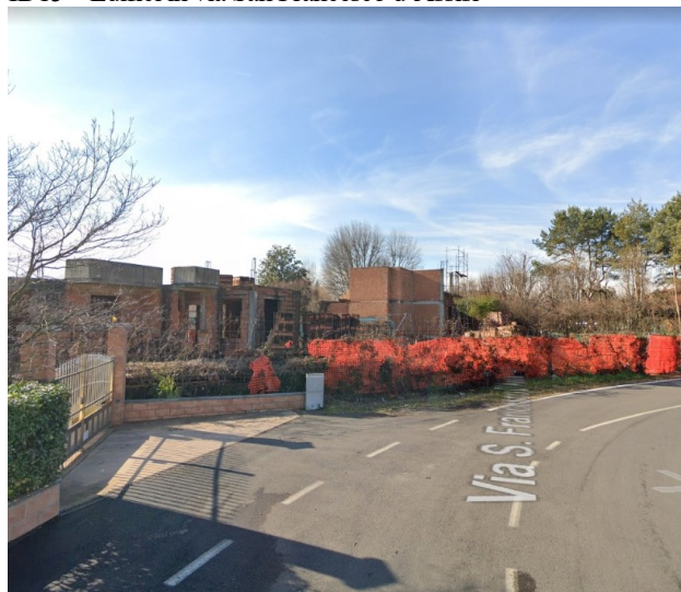
ID15 – Edifici in via San Francesco d'Assisi
