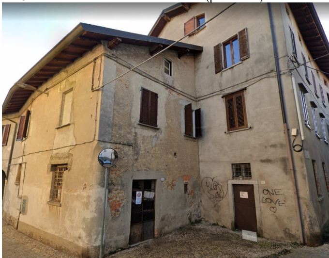
ID18 – Porzione di edificio in via Manzoni (piano terra)
