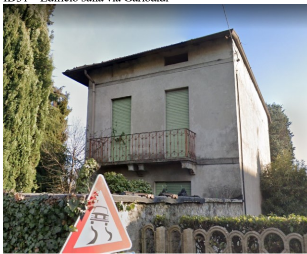
ID31 – Edificio sulla via Garibaldi
