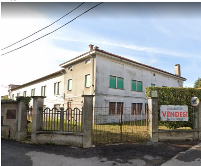
ID08 – Edificio in via Volta
