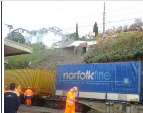
San Nazzaro (CH) – frana su linea - 11/2008
