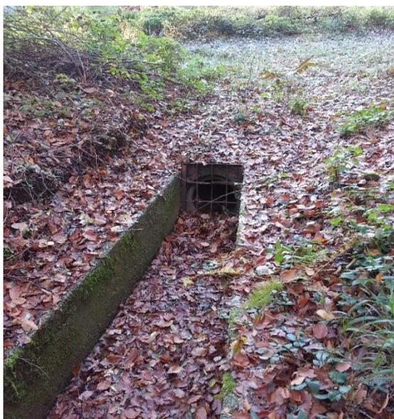
Foto – sx. Versante a monte di via XXV aprile soggetto a dissesti franosi (frana 04/2013) – Griglia a rischio ostruzione in prossimità della ditta Zanollo
