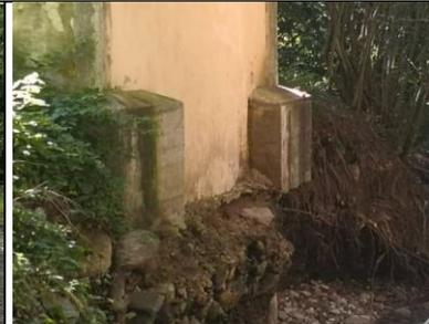
Foto. Ponte SP45 Chiuso per erosione - 06-2020
