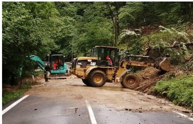
Foto– Sx. 11/2019 Allagamenti su SP45 . Dx. Rimozione materiale solido provocato da frana lungo la SP45 del 06/2020. Fonte Volontari PC Valcuvia
