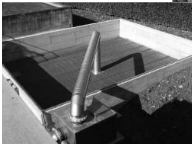
Sopra: vasca di contenimento del materiale filtrante e blocco ventilatore.
